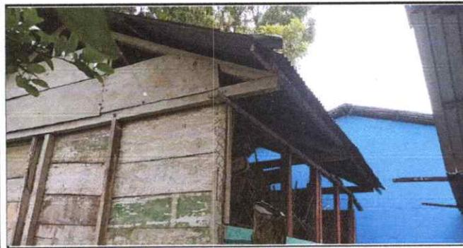
Foto 5: el mobiliario que se resguarda en la bodega 1 se ve afectada ya que las laminas se deterioraron con el paso del tiempo
