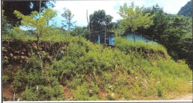
Foto 2: el deslave afecta al establecimiento un 90 por ciento ya que la infraestructura se está deteriorando (socavamiento).
