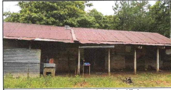
Foto 6: en la bodega dos también se ve afectado el mobiliario que se resguarda ya que las laminas sufren perforaciones por las constantes lluvias.
