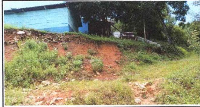
Foto 4: se necesita un muro perimetral que cubra el área afectada ya que corre en peligro la integridad física de los niños y niñas.
